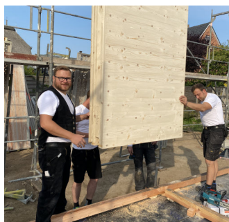
Stefan Mojen (li.) von Mojen Bauregie auf der Baustelle von „Bastian 26“.
